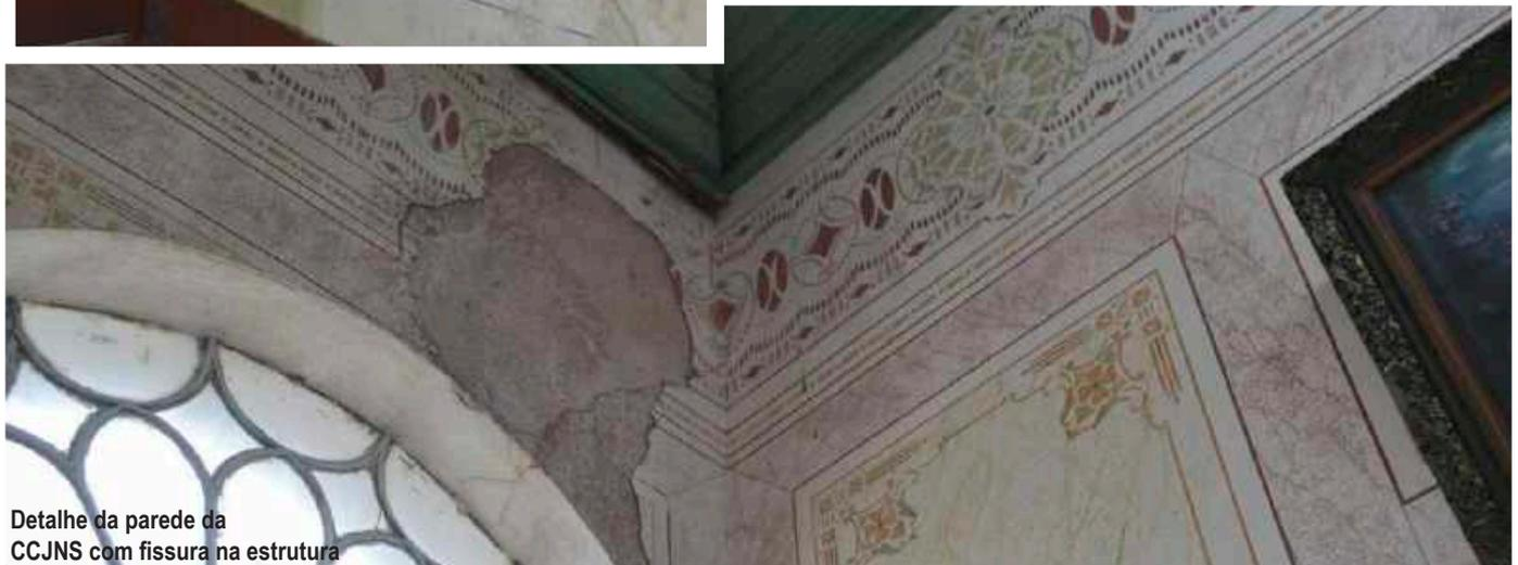
Detalhe da parede da CCJNS com fissura na estrutura
